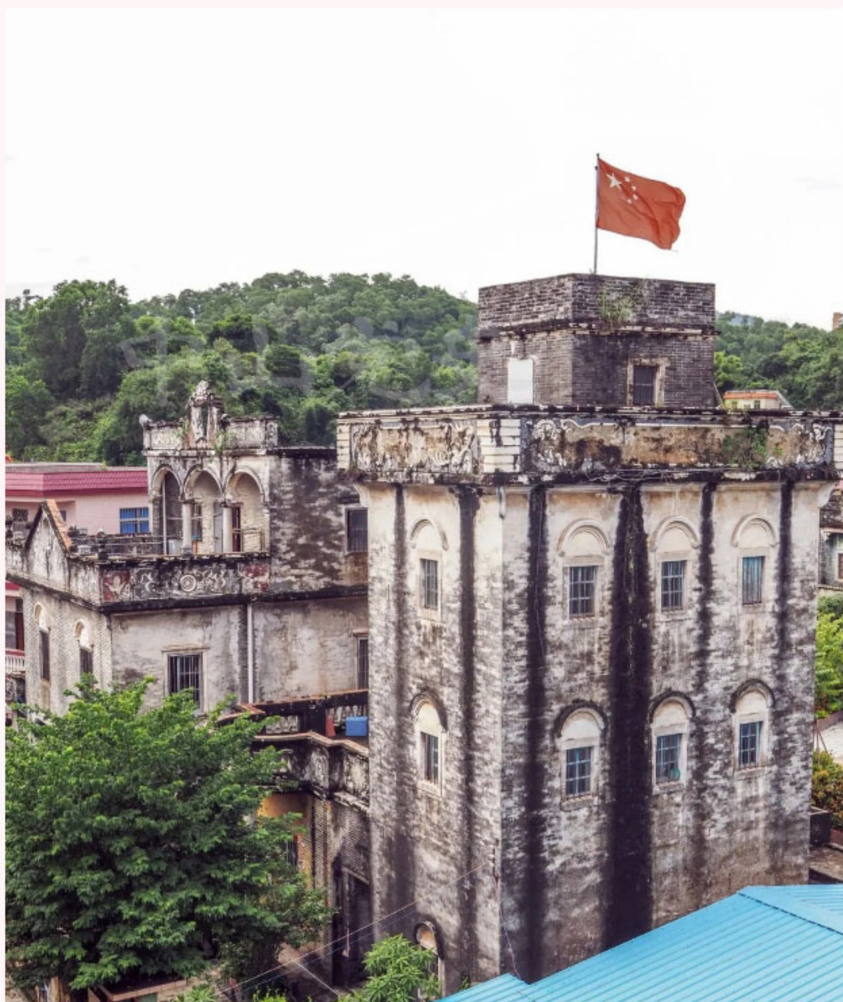
白鸽队队部旧址远景全貌（黄春华 摄于2020年10月）
