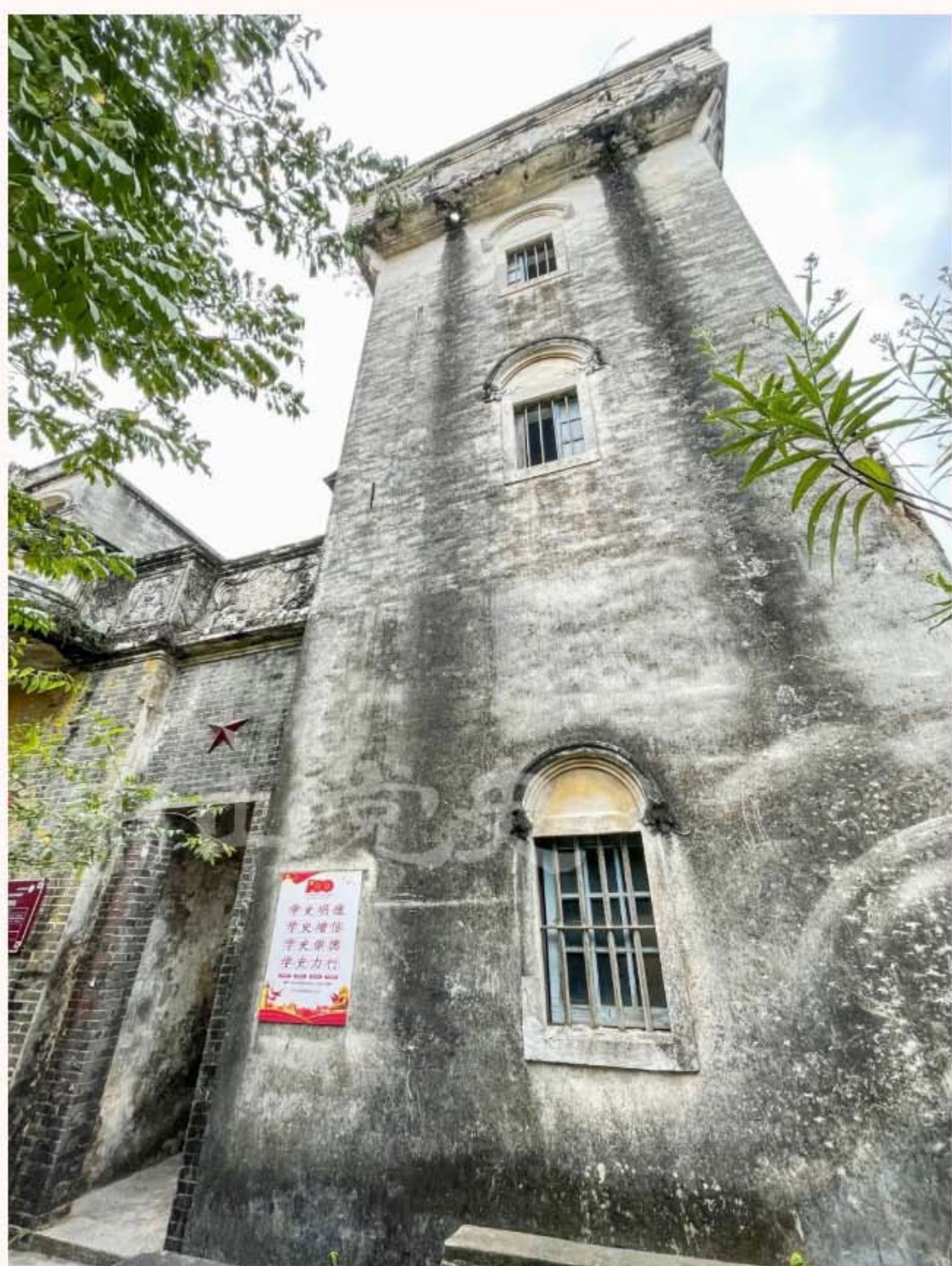
▲白鸽队队部旧址碉楼正面（黄春华 摄于2022年2月）
