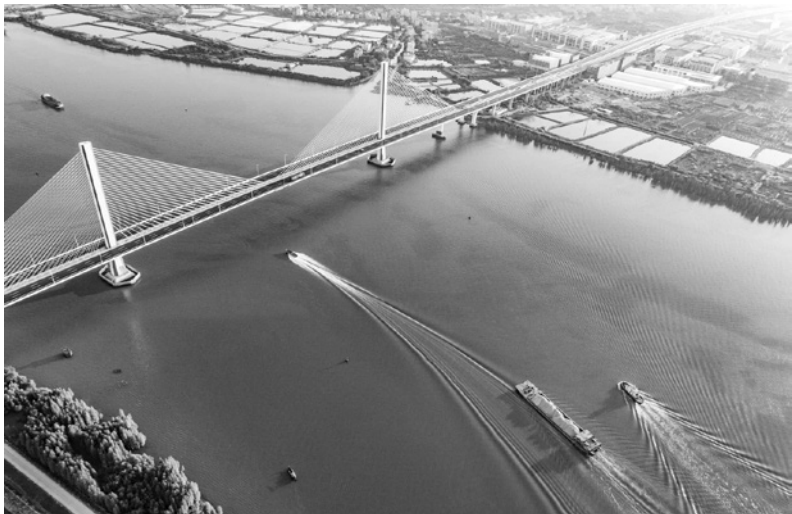
2020年12月28日，广中江高速公路第三期工程（除公铁共建段外）通车。图为该高速路洪奇沥水道大桥（黄春华/摄）
