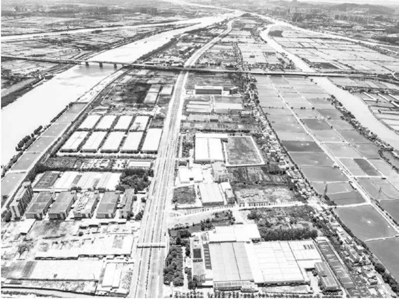
2020年7月1日，沙港路改建北二环路工程全线通车（黄春华/摄）
