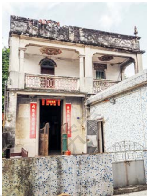
中区纵队交通总站旧址正侧面 (黄春华摄于2020年10月)
