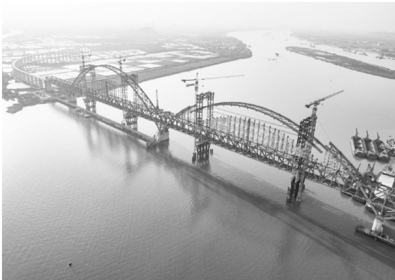
2021年2月，位于黄圃镇的南沙港铁路跨洪奇沥水道大桥第二拱吊升合龙，这在亚洲同类桥梁中跨距第一（黄春华/摄）
