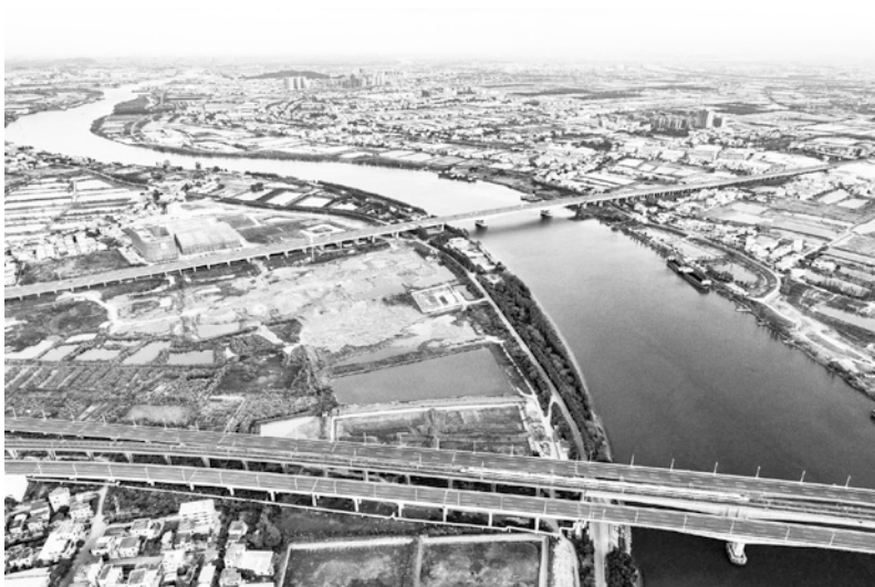
十水线及广珠城际跨鸡鸦水道大桥（黄春华 / 摄）
