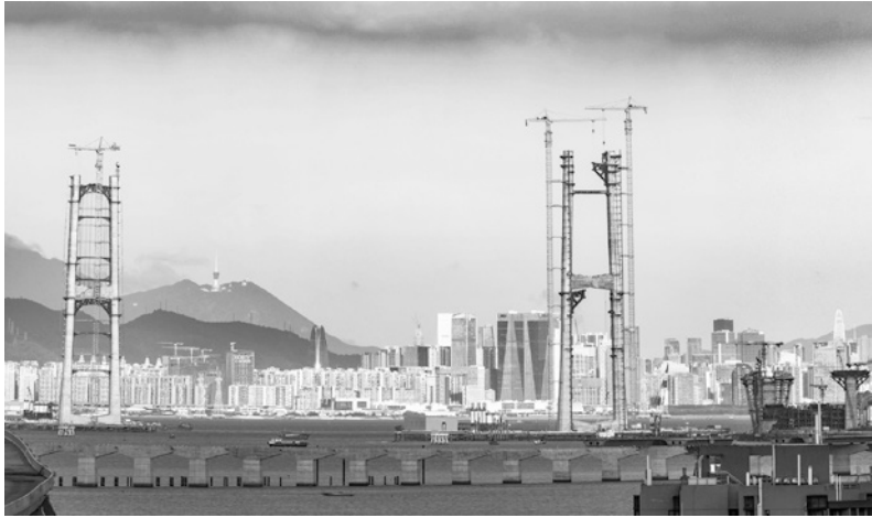
2021年9月拍摄的深中通道伶仃洋大桥（黄春华/摄）
