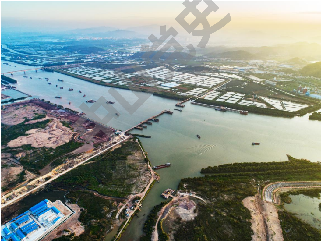
中开高速公路中山段控制性节点工程横门西水道特大桥在建设中
