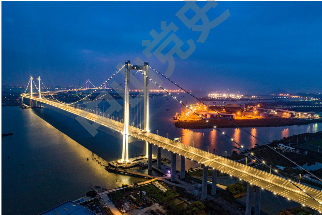
南沙大桥，建设时曾名为虎门二桥 黄春华摄于 2019 年 3 月
