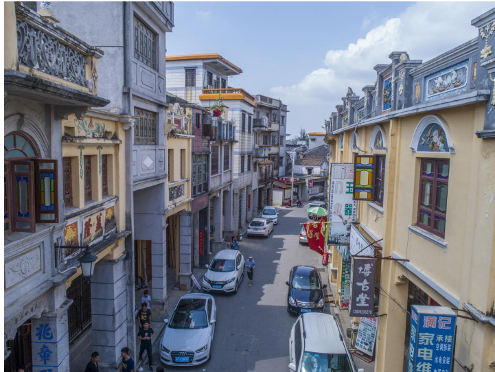
珠海市斗门区斗门镇斗门大马路 黄春华摄于2017年4月
