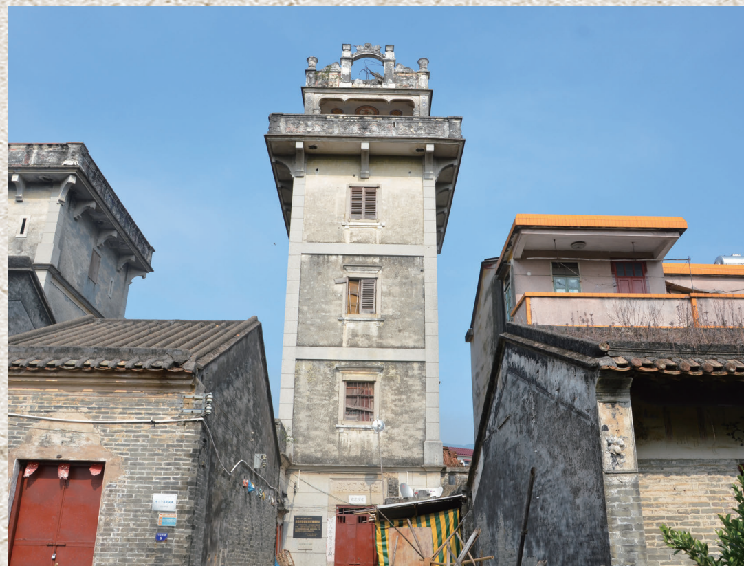
位于三乡镇白石村门前大巷7号的白石防御战指挥碉楼旧址。
